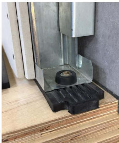
Guia metálica apoiada sobre a ISOGUIA e fixada com o Pflex.
