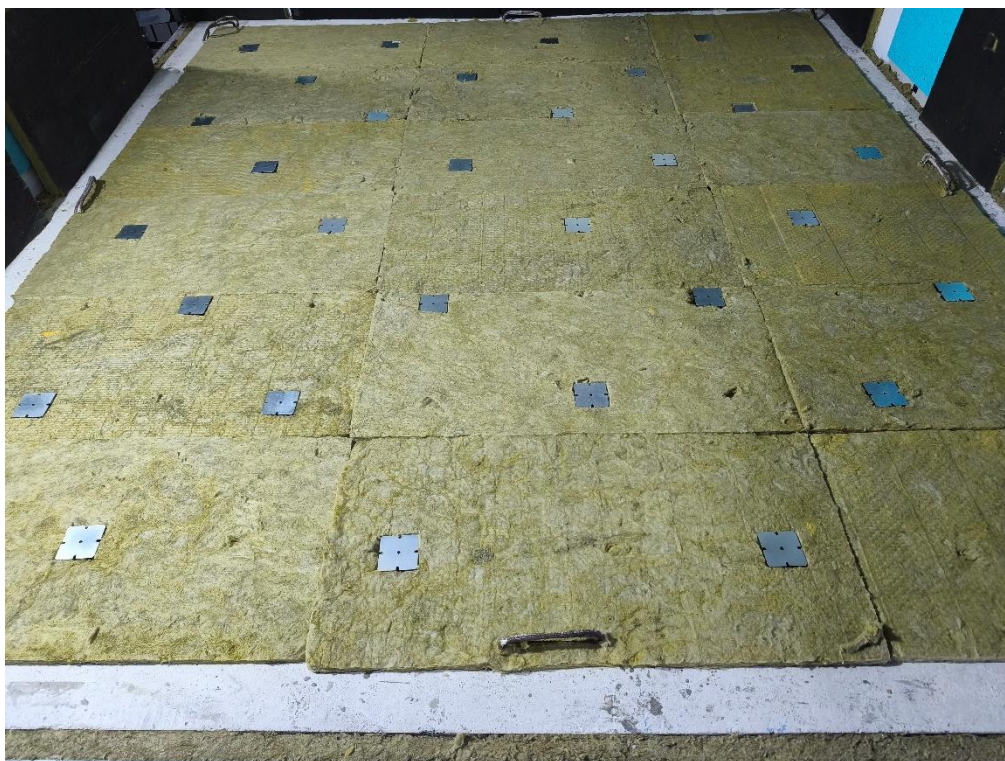
Foto A.2: Montagem da amostra ensaiada.
